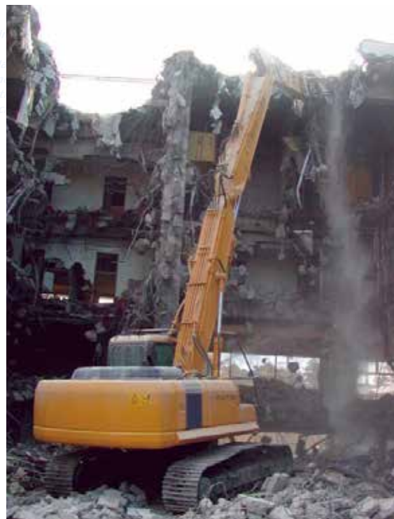
解体作業現場
