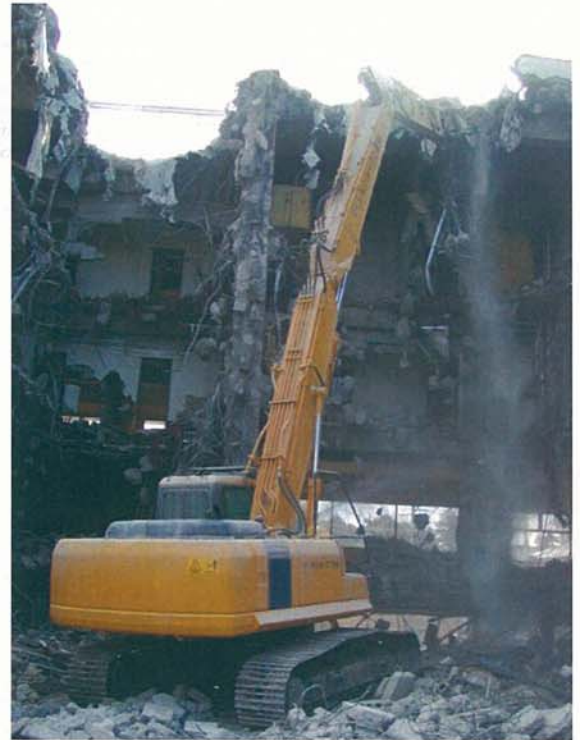
解体作業現場
